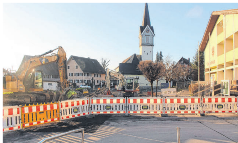
Straßenbau im Hohenweiler Zentrum: die Verkehrsfreigabe ins Oberdorf steht bevor.
